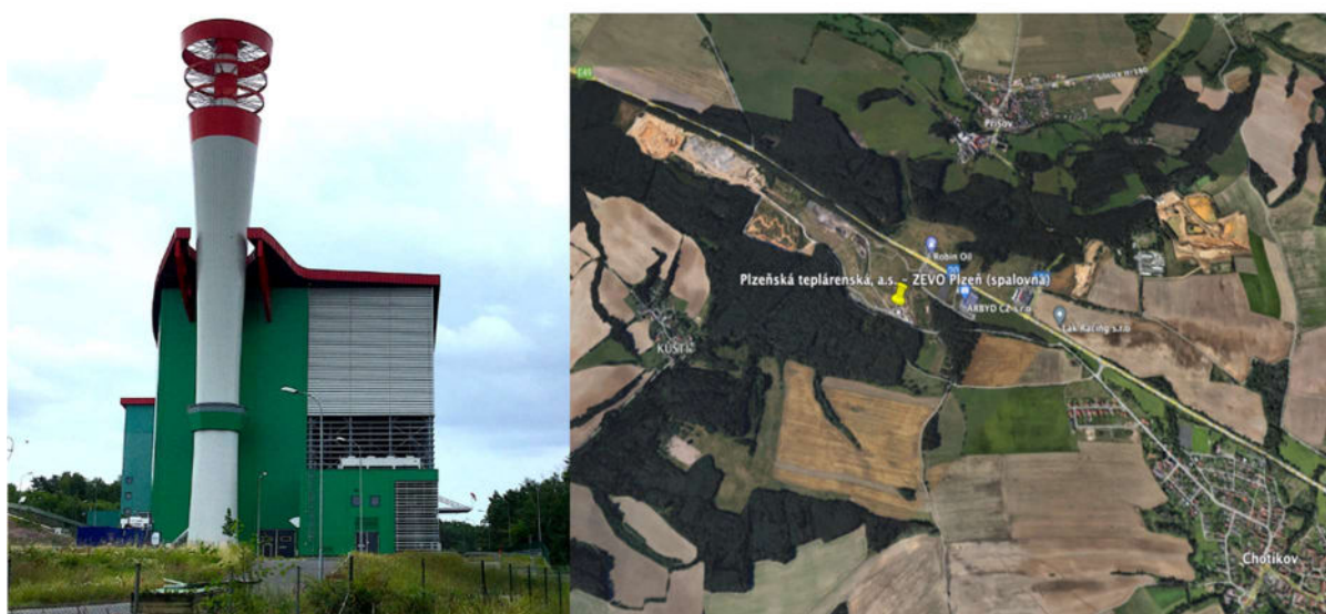
Figure 1: ZEVO Plzeň of Plzeňská teplárenská
