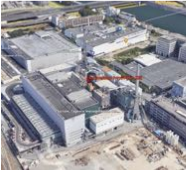
Figure 1 : Incinérateur Ivry-Paris XIII Ivry-Paris XIII (Google Earth)
